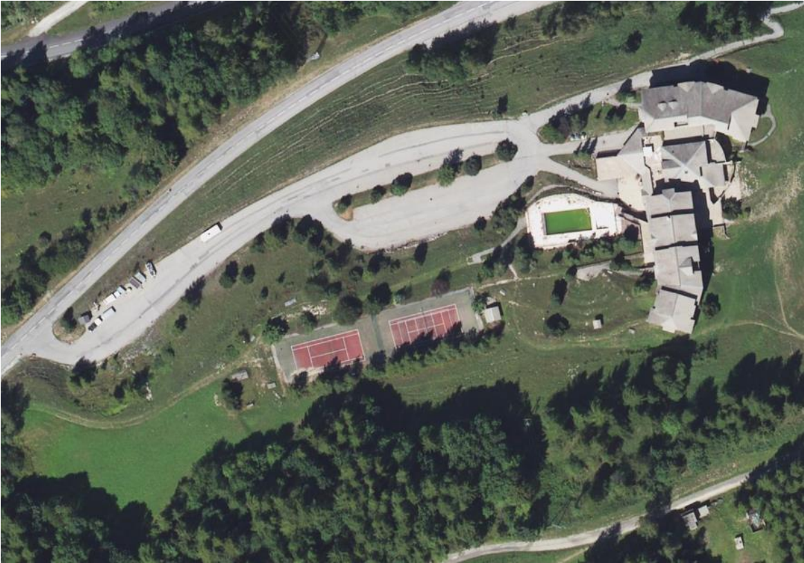
Photos espaces de stationnement et de voiries secteur Ouest
